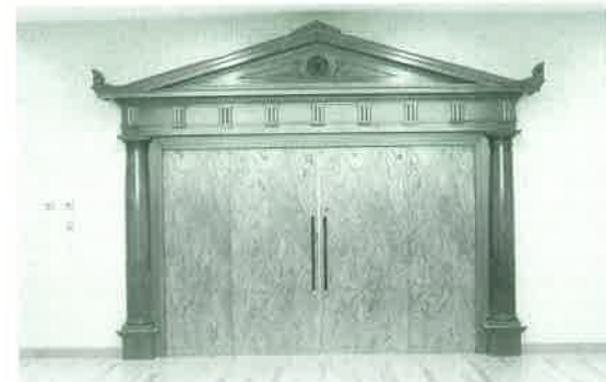
旧中学校の講堂の正面飾りを移築
