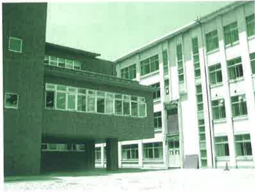
2階に配置された職員室
